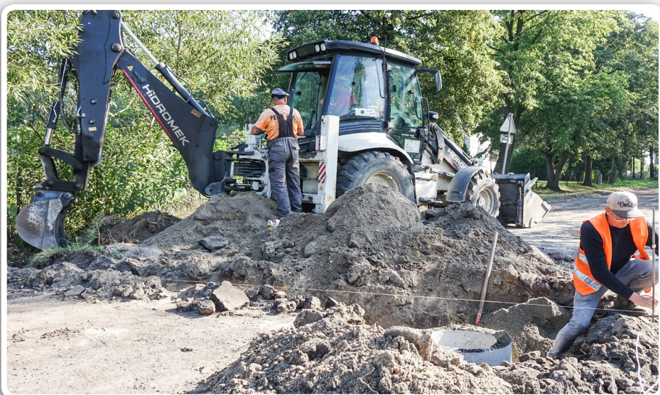
Przebudowa drogi przy szkole w Dobrzelowie zakończy się w listopadzie.
