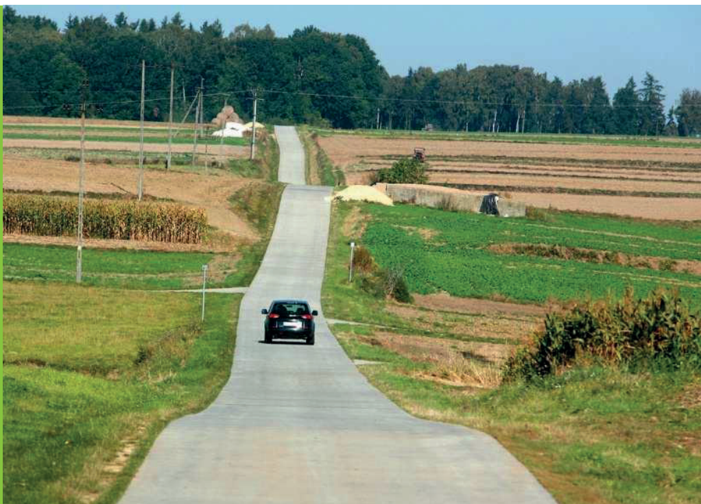
Betonowe drogi powstają w różnych gminach na terenie kraju. Są znacznie tańsze niż asfaltowe, wytrzymałe, a do tego świetnie sprawdzają się w warunkach zimowych.
